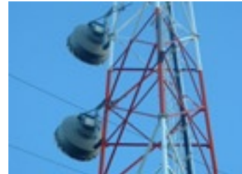
Instalación de MMOO Ericcson Mini LinK
