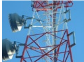
Instalación de MMOO Ericcson Mini LinK
