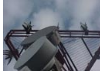
Desmontaje de MMOO
