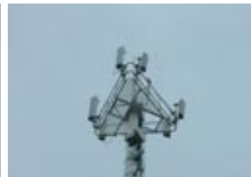
Instalación de MMOO Ericcson Mini LinK
